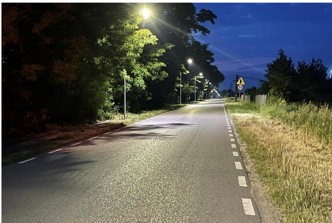
Wybudowane oświetlenie w Trębkach Nowych
