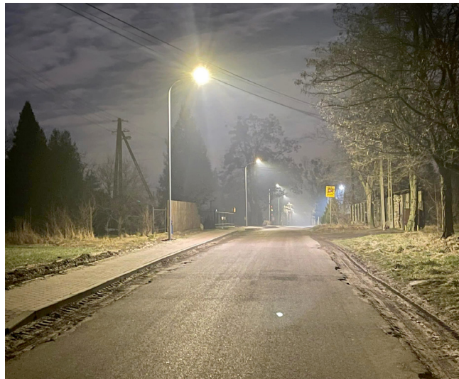
▲ Oświetlenie drogi w Trębkach Nowych
