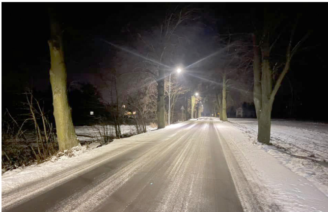
▲ Oświetlenie drogi w Śniadowie
