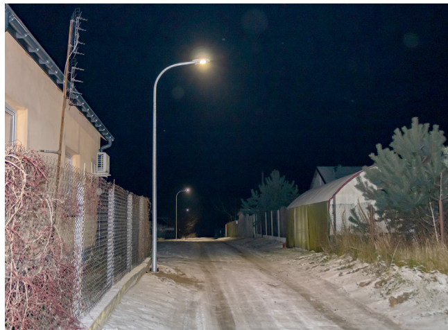
▲ Oświetlenie drogi w Wojszczykach
