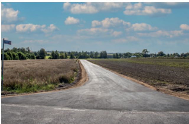
▲ Droga w Trębkach Nowych
