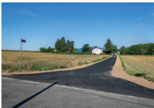
▲ Droga w Trębkach Nowych
