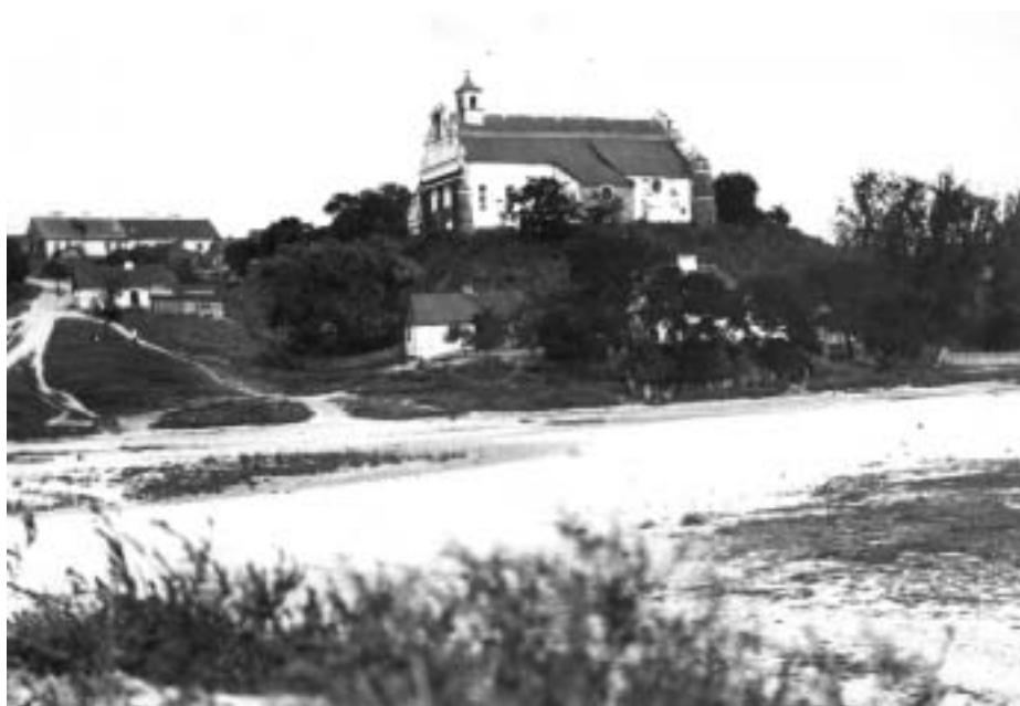
Wzgórze kościoła od strony Kępy Zakroczymskiej. Fot. H. Poddębski
