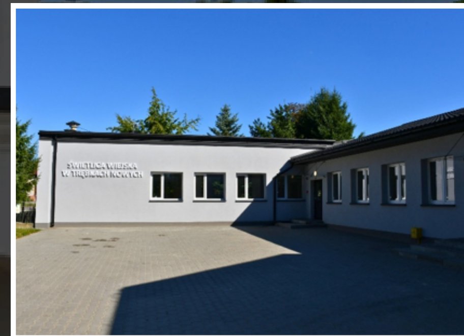
Modernizacja świetlicy wiejskiej w Trębkach Nowych
