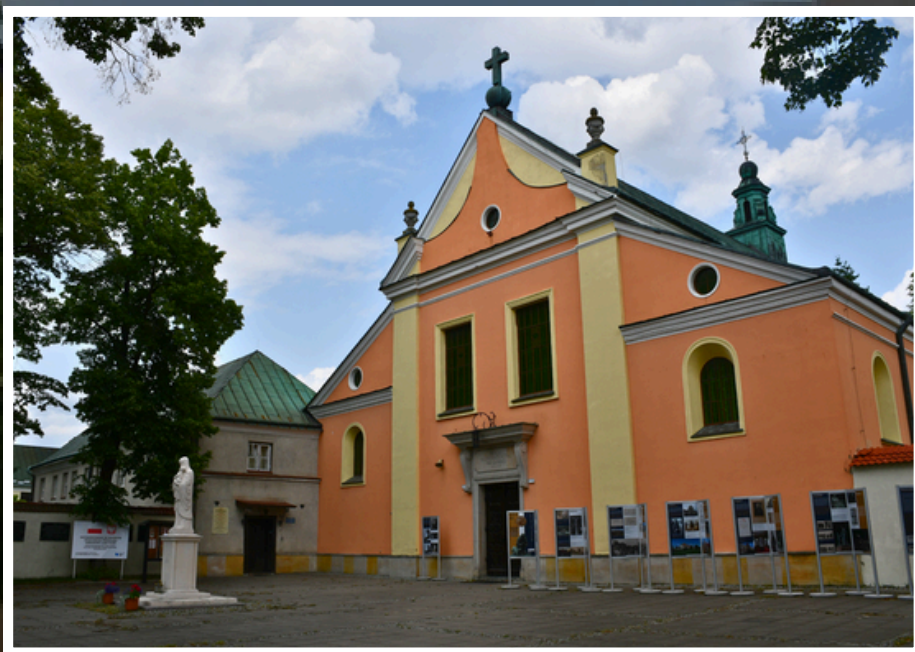
Remont zabytkowego budynku klasztoru ojców Kapucynów w Zakroczymiu
