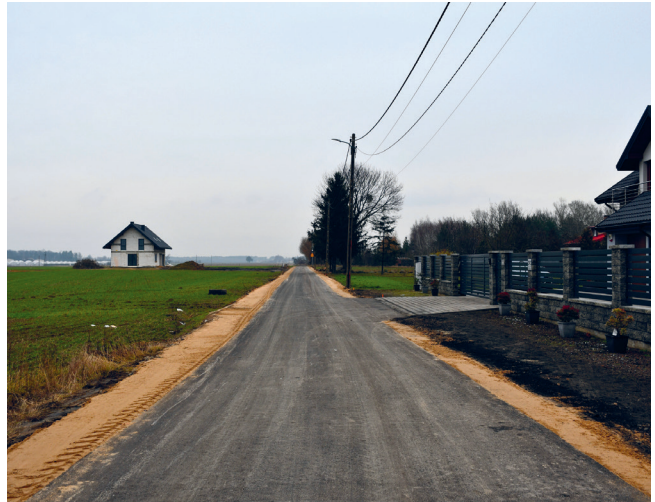
▲ Przebudowany odcinek drogi gminnej w Strubinach
