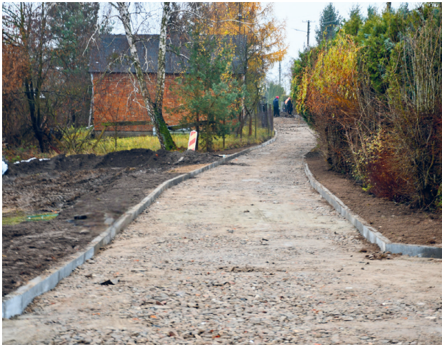
▲ Przebudowywany odcinek drogi gminnej w Wólce Smoszewskiej
