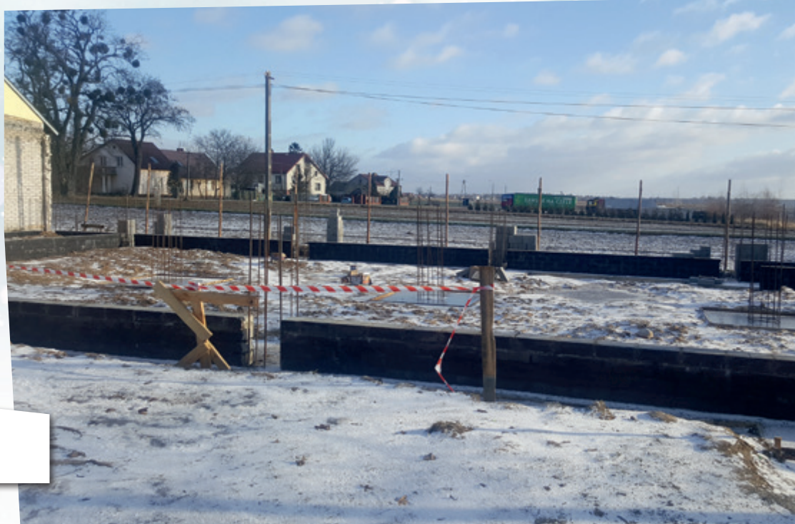
► Budowa strażnicy OSP – Trębki Nowe
